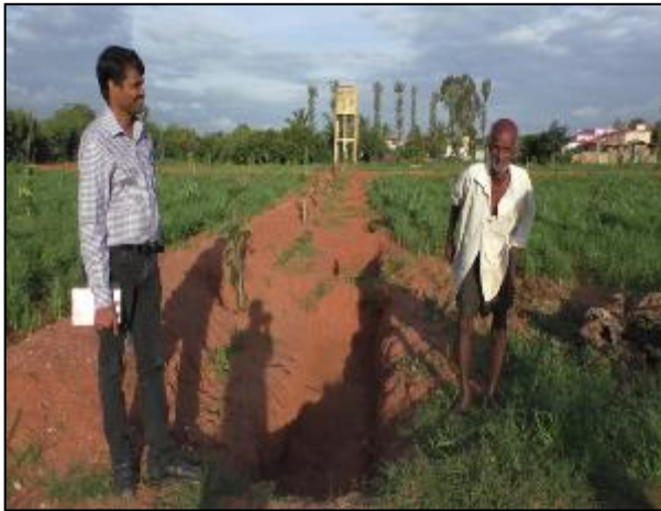
Trench cum bund, Mudavatti
