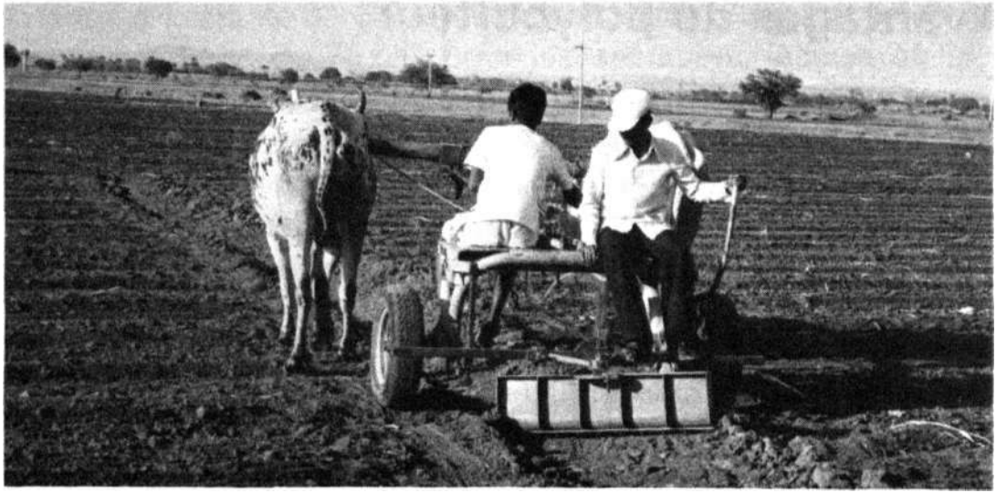
Construction d'un fosse de drainage a l'aide d'une lame niveleuse a angle réglable.
